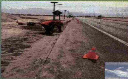
Se aprecia el corte del pavimento y excavación de una zanja para realizar la colocación de las soleras.
